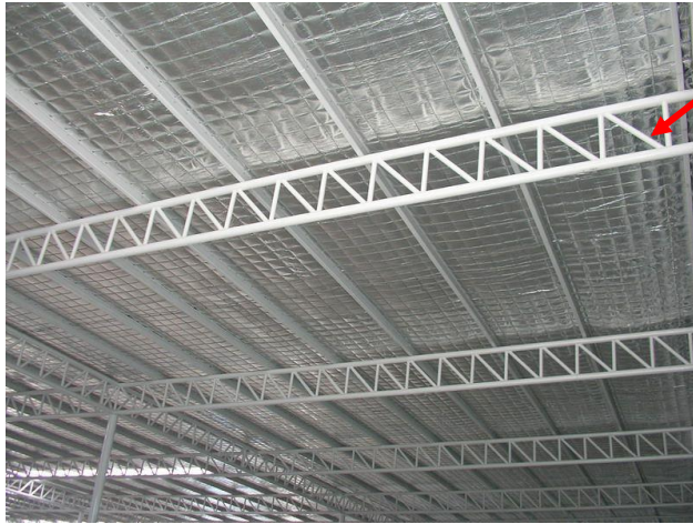
Truss structure รองรับ Grid pipe
